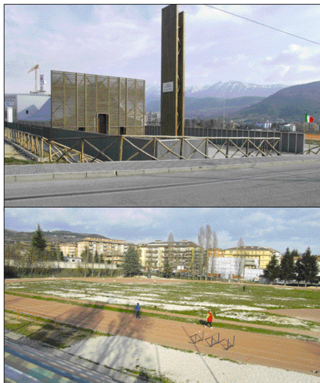
Piazza multiuso. La pista di atletica, utilizzata nell'immediato post-sisma come tendopoli, e il complesso ecclesiale di San Bernardino progettato da Antonio Citterio e realizzato fra fine gennaio e inizio aprile 2010
