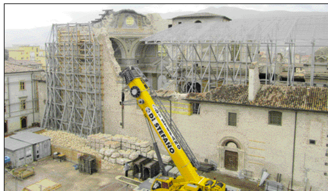
La chiesa di Santa Maria Paganica, dove è stata da poco ultimata la copertura per la protezione dell'interno
